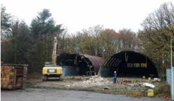
Alle ruimte om te slopen.
